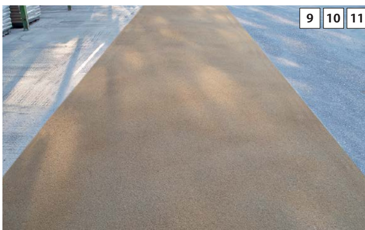
乾燥後にトップコートを塗布 マスキングを撤去して完成
