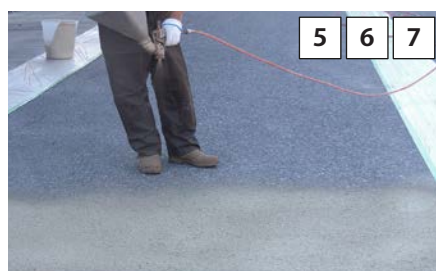
平米使用量に従って均一に吹き付け
